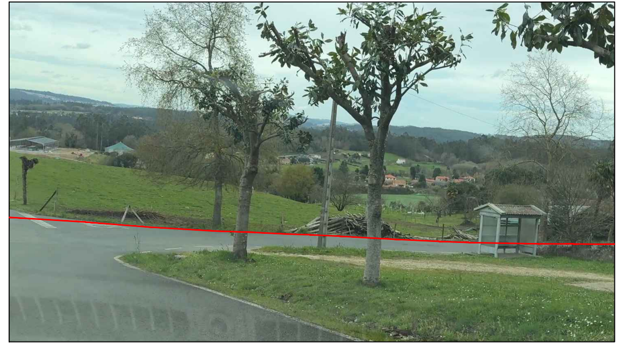
Afección a Iglesia de Lestedo Canalización subterránea
